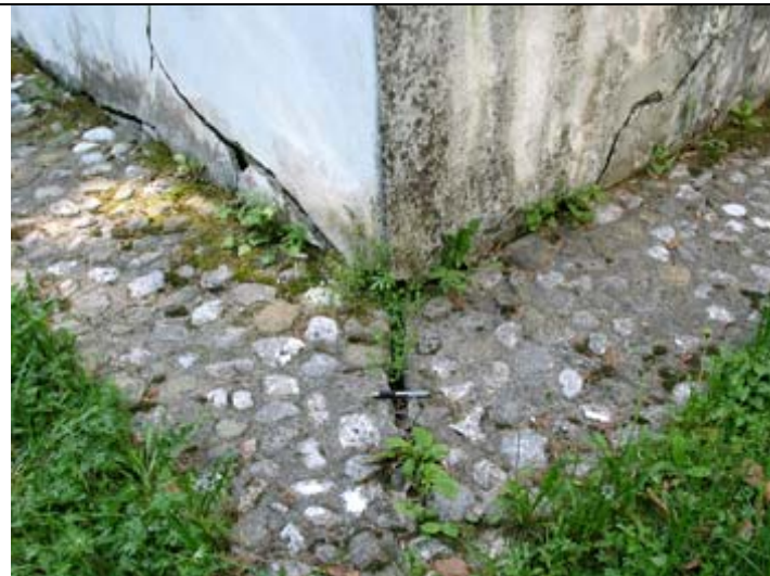
Foto delle crepe di cedimento già presenti alla base del Santuario della Madonna di Raveo
