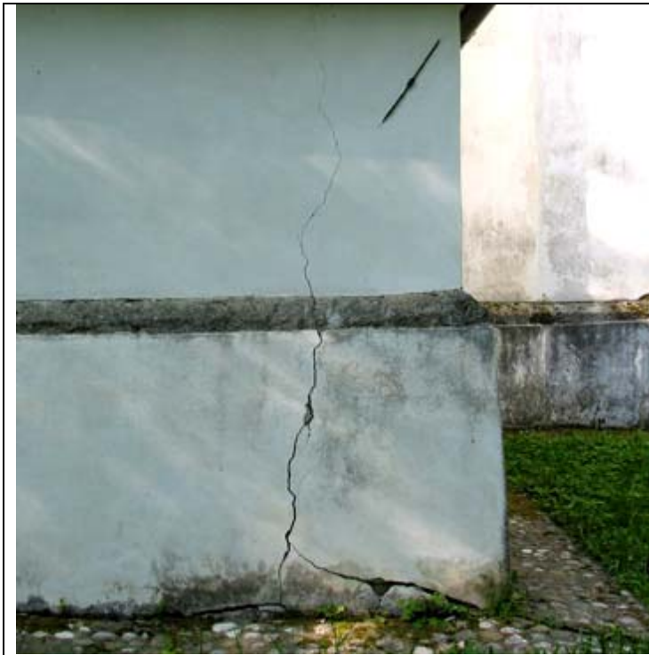
Foto delle crepe di cedimento già presenti alla base del Santuario della Madonna di Raveo
