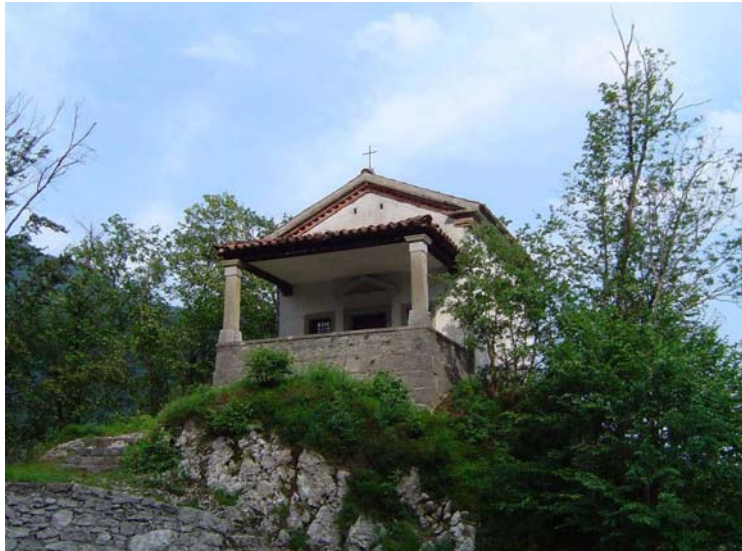
Chiesetta di Terranera com'è attualmente
